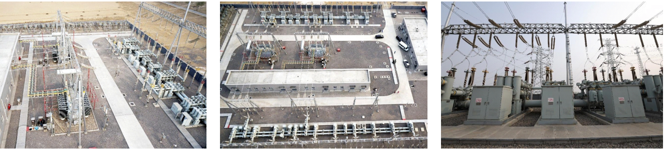
▲ 国网冀北220kV碣石变改造项目
