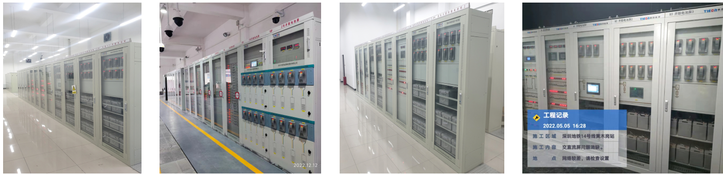
1.变电站直流电源系统 2.变电站模块化直流电源系统 3.并联通信电源系统 4.轨道交通直流电源系统
